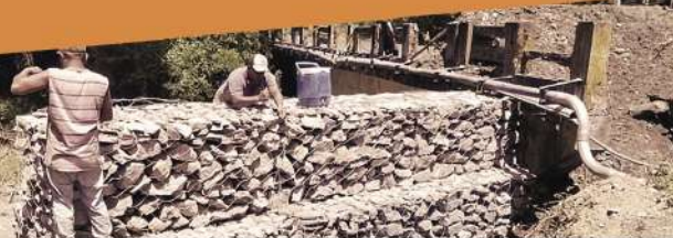
Construcción de muros de contención con gaviones
